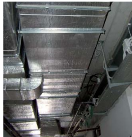
Ortakiai padengti Trocellen DUCT CL1 AL
