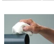
Dėl greito garavimo ir cheminės sudėties klijai ir valiklis yra labai degios medžiagos. Šias medžiagas laikykite atokiai nuo liepsnos židinių. Dirbdami nerūkykite. Venkite kontakto su oda ir akimis. Stenkitės neįkvépti šių medžiagų garą.
